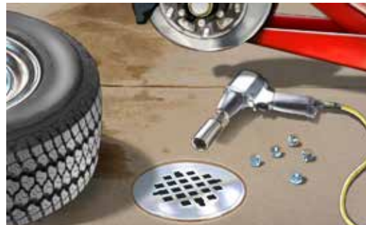
污水排水孔： 流向污水處理廠的室內排水孔。
