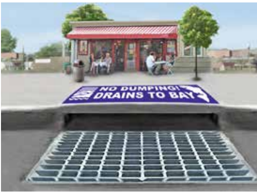
Cống Thoát Nước Mưa: Cống ngoài trời chảy trực tiếp vào các nhánh sông và Vịnh.
