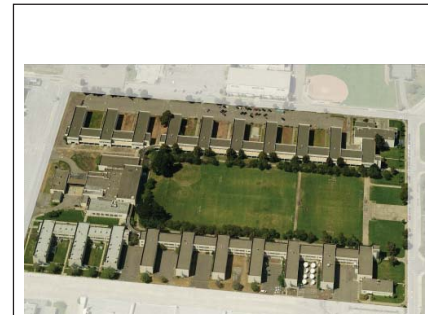
Adaptive Reuse (BEQ)
